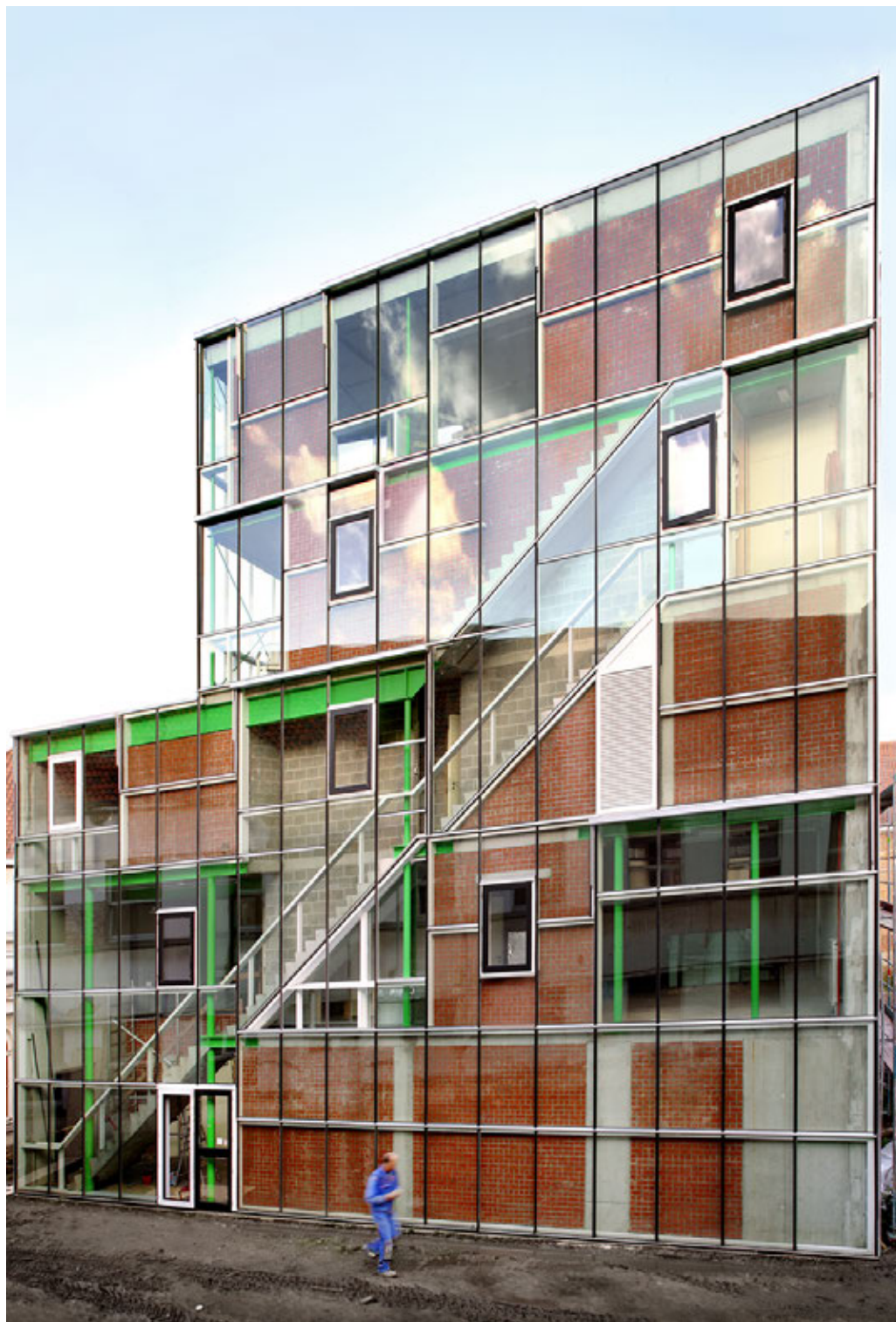
'studios Les Ballets C de la B and LOD' jan de vylder en trice hofkens architecten jan de vylder architecten (+ inge vinck)
